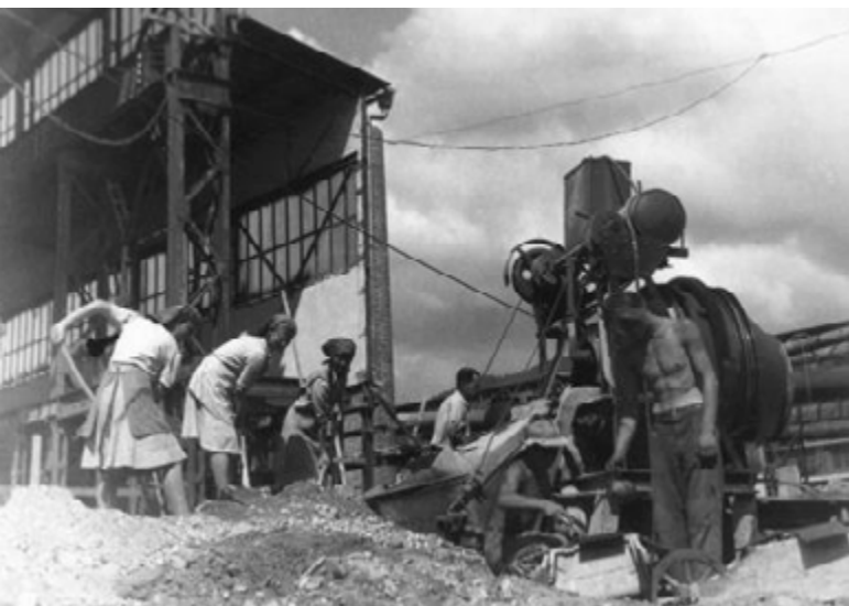
Delavke pri gradnji novih obratov v železarni po letu 1945
