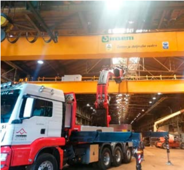
Montaža novega žerjava v hali D obrata PDP
